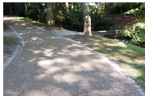
slijtlaag op geasfalteerde parkpaden
